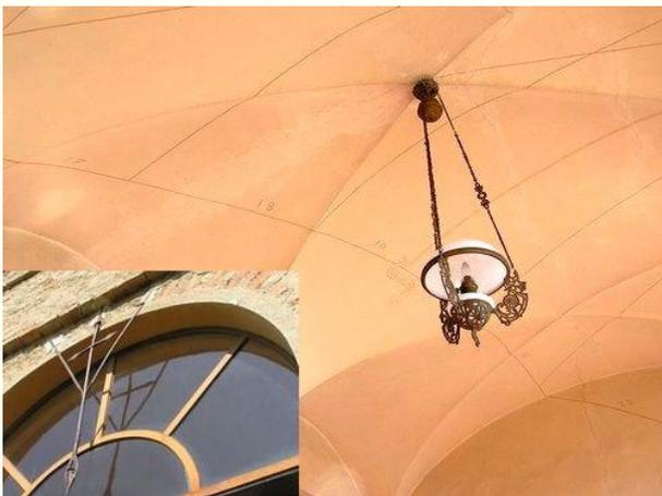
**Abb.5** Reflex-Sonnenuhr in einem Raum mit Gewölbe-Decke, horizontaler Spiegel im Oberlicht der Eingangstüre (in der Spitze des Pfeilförmigen Halters, s. Beibild), DGC 14102
