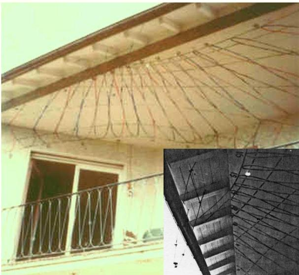
**Abb.6** Reflex-Sonnenuhr auf einem Balkon, horizontaler Spiegel mit Gestänge an der Decke befestigt (siehe Beibild) DGC 8705
