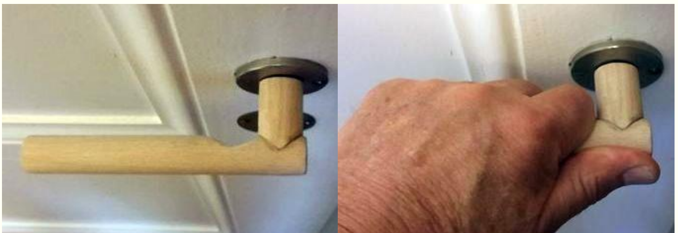
Abb.n 17 u. 18 Zimmertüre mit Funktionsmuster des Türdrückers nach Entwurf #1
